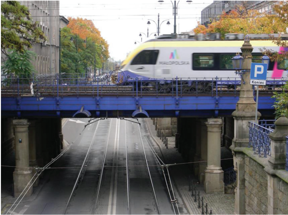
Fot. 3. Wiadukt nad ul. Lubicz w Krakowie
