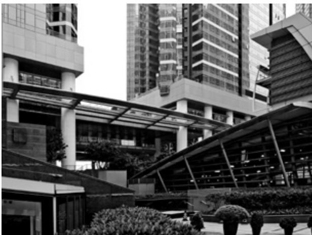
il. 2. Wielopoziomowy dziedziniec Union Square pełen roślinności, w tle The Cullinan (proj. Wong & Ouyang), fot. Mariusz Twardowski / Multilevels courtyard Union Square, in the background The Cullinan (designed by Wong & Ouyang), fot. Mariusz Twardowski
