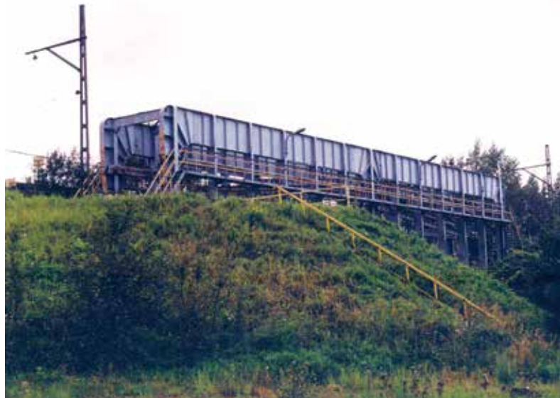
Most rozładunkowy piasku na terenie KWK Kleofas w Katowicach (lato 2001)
