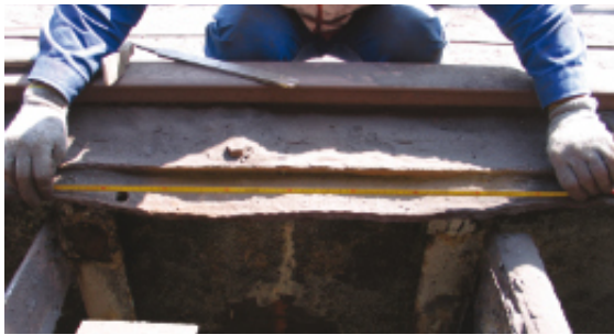
Rys. 9. Trwała deformacja o strzałce f=38 mm na długości 800 mm nadmiernie pocienionej górnej półki belki wewnętrznej od strony belki zewnętrznej w środku rozpiętości belki pomiędzy osiami 131-132 [1]
