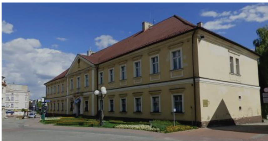
Fot. 1. Dawny pałac rodziny von Dietrichsteinów, elewacja główna i boczna – stan przed remontem kapitalnym, fot. Robert Hood, 2016, lic.: KFree
