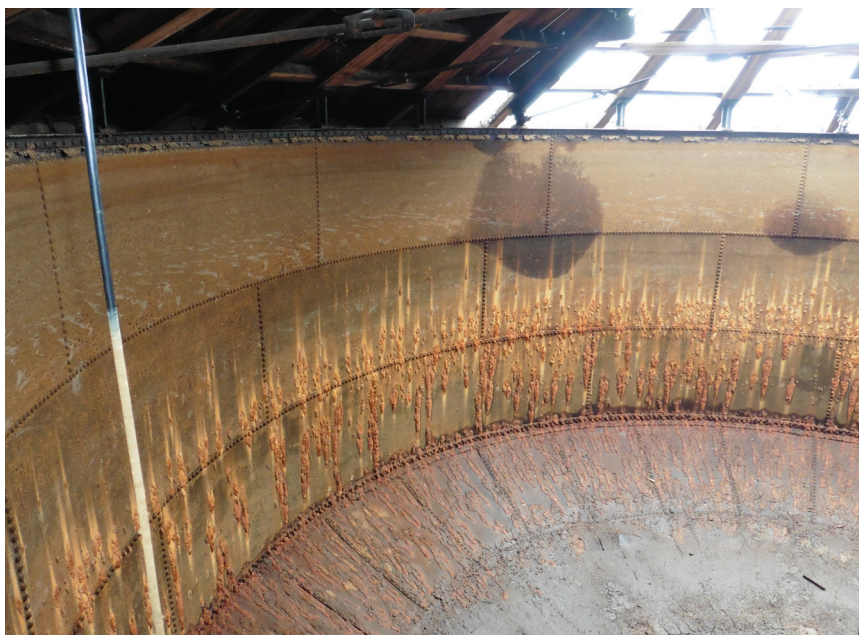
Fot. 2. Widok fragmentu wnętrza zbiornika przed remontem
