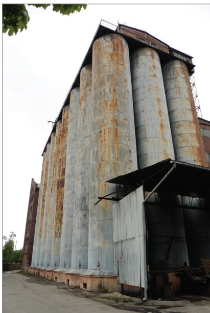
Fot. 4. Bateria stalowych silosów z 1934 r. na terenie Młyna Hilberta w Dzierżonowie
