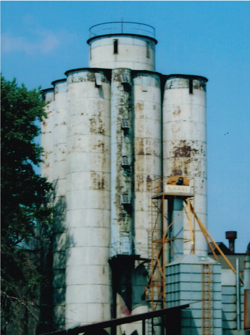
Fot. 6. Bateria stalowych silosów z 1935 r. w Jaworze
