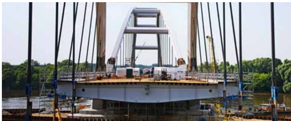
Budowa mostu drogowego przez Wisłę im. gen. Elżbiety Zawackiej w Toruniu
