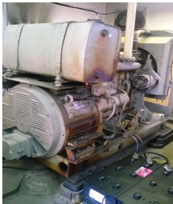
Rys. 2. Osadzenie na fundamencie ramy agregatu: silnika, prądnicy, chłodnicy, zbiornika paliwa oraz baterii akumulatorów rozruchowych
