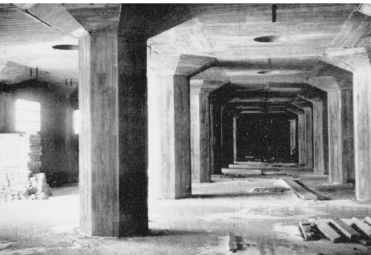
Fig. 8a. Grain elevator of Csepel (1926–28, designed by Professor Mihailich and Professor Hüttl) © Credit: “A M. Kir. budapesti vámmentes kikötő gabonatarháza” (1935), Vízügyi Közlemények , Vol. 17, No 4, 565.
