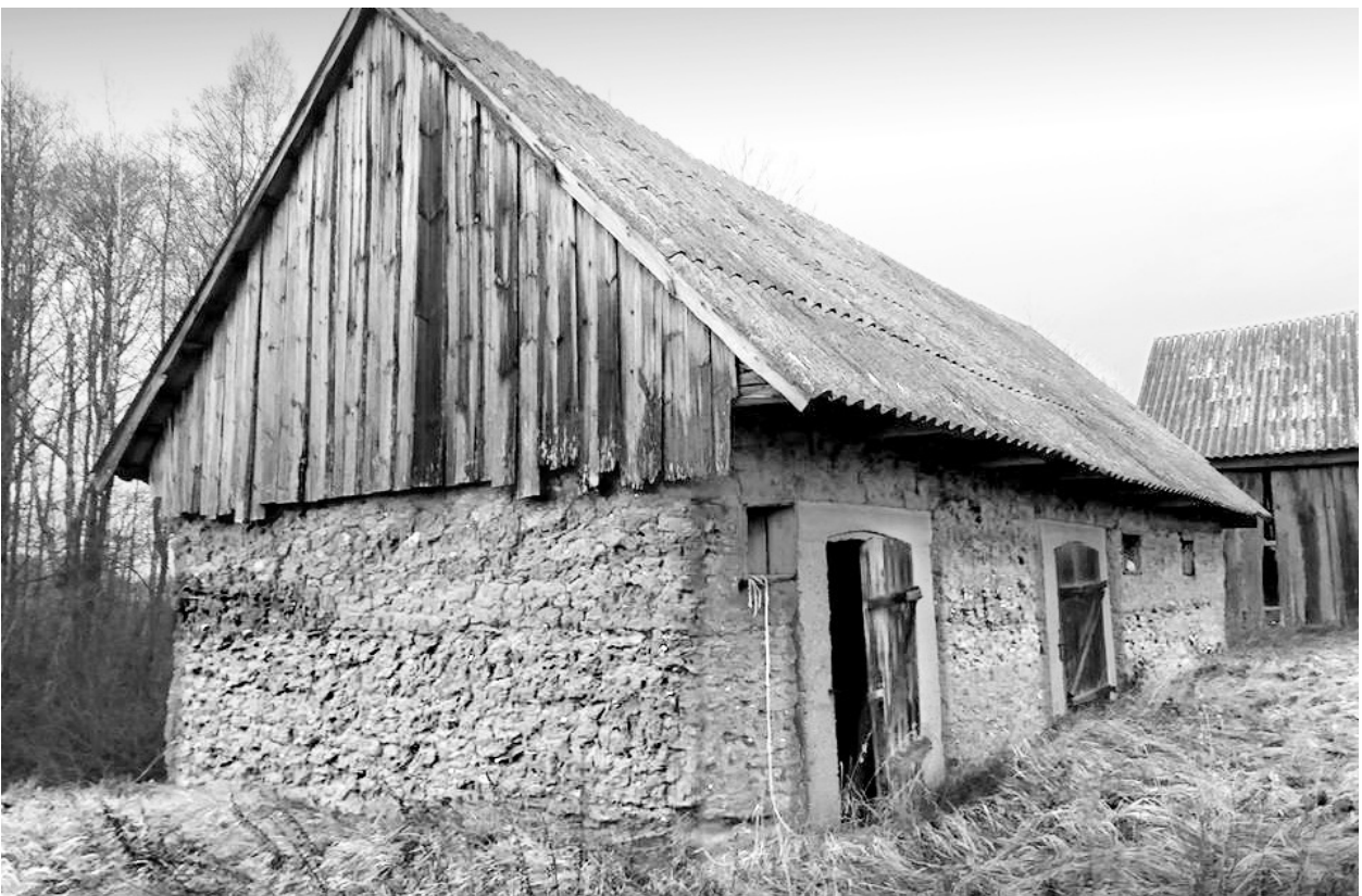
Ryc. 6. Budynek gospodarski we wsi Daniłowce w gminie Giby; źródło: fot. autorzy, 2016 Fig. 6. An earthen barn in Daniłowce, Giby commune; source: photo by the authors, 2016
