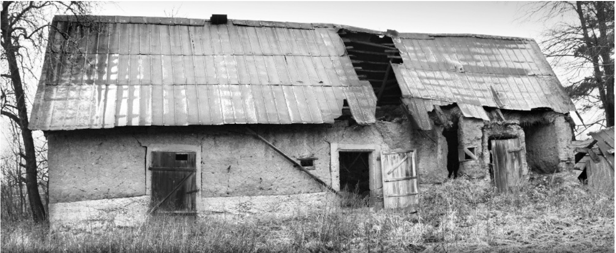
Ryc. 5. Budynek gospodarski we wsi Daniłowce w gminie Giby; źródło: fot. autorzy, 2016 Fig. 5. An earthen barn in Daniłowce, Giby commune; source: photo by the authors, 2016
