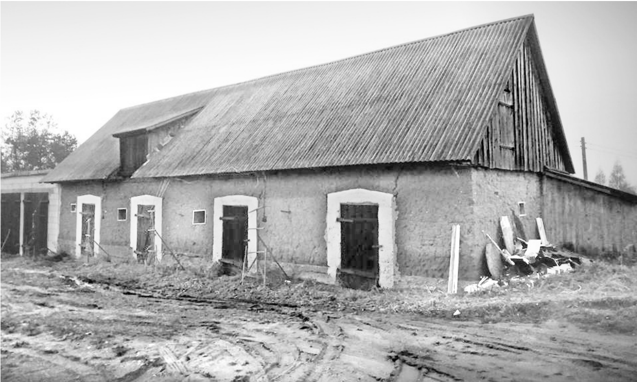
Ryc. 3. Budynek gospodarski we wsi Białowiersnie w gminie Giby; źródło: fot. autorzy, 2016 Fig. 3. An earthen barn in Białowiersnie, Giby commune; source: photo by the authors, 2016
