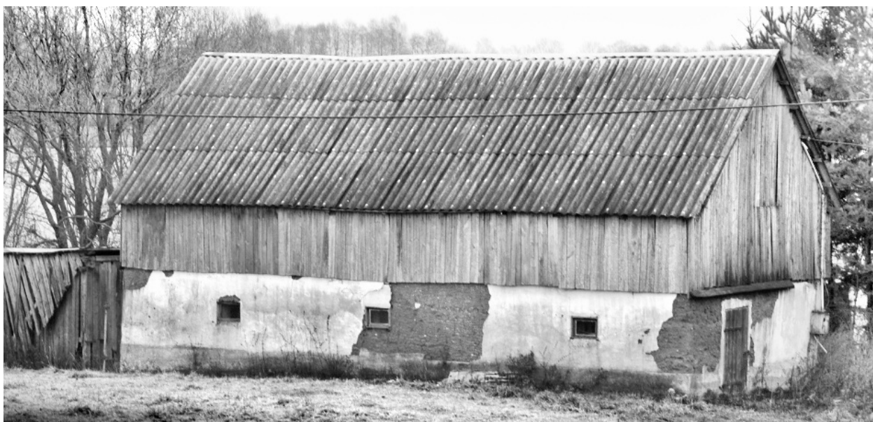
Ryc. 13. Chlew z drewnianą ścianką kolankową w Białogórze w gm. Giby; źródło: fot. autorzy, 2016 Fig. 13. An earthen barn with a timber hayloft in Białogóra, Giby commune; source: photo the authors, 2016
