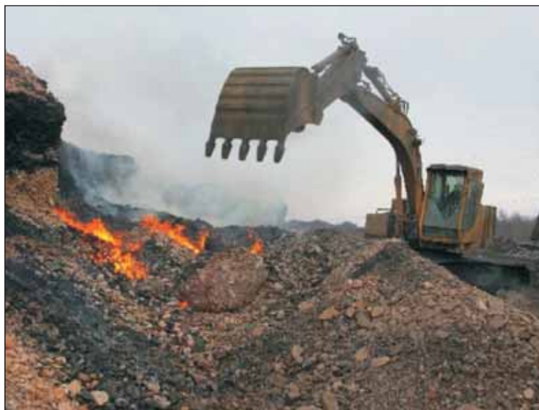
Fig. 1. Prace gaśniczo-prewencyjne prowadzone na terenie zwałowiska odpadów powęglowych w Rudzie Śląskiej (Projekt COOL'S)
