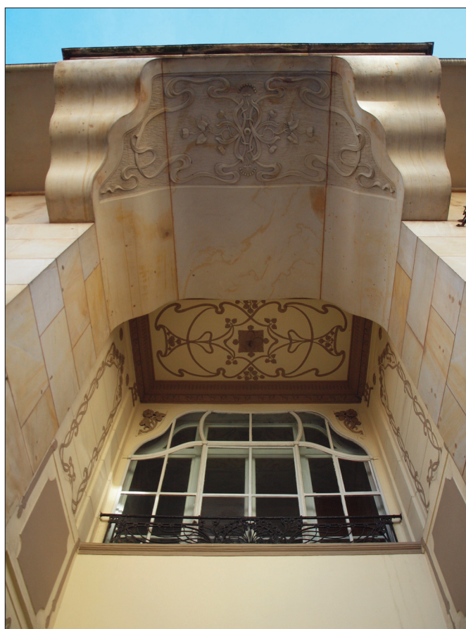
6a, b. Secesyjna brama i sklepienie w kamienicy nr 69. Fot. P. Szumigala, 2017 r. 6a, b. The Art Nouveau gate and vault in tenement house No. 69. Photos by P. Szumigala, 2017
