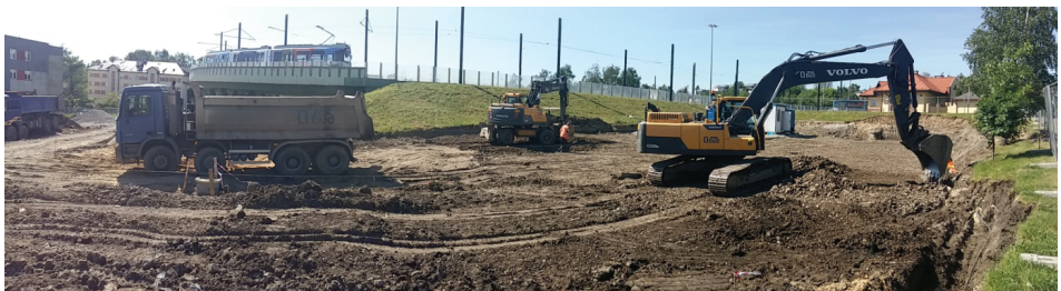
Fot. 1. Prace ziemne Autor: materiał własny RUiBD Sp. z o.o.
