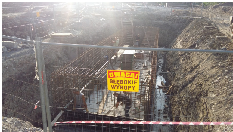
Fot. 3. Budowa zbiornika retencyjnego Autor: materiał własny RUiBD Sp. z o.o.
