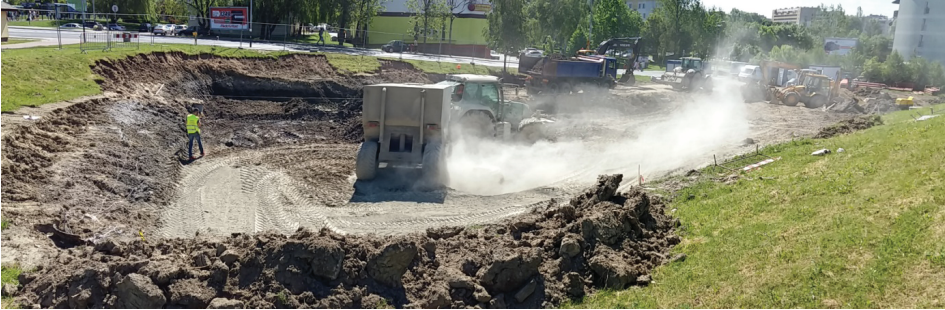
Fot. 2. Stabilizacja podłoża Autor: materiał własny RUiBD Sp. z o.o.
