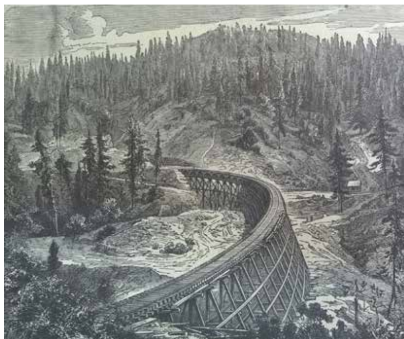
Il. 1. 1. Amerykański wiadukt drewniany typu „trestle” Der Weltverkehr und seine Mittel , 1. Teil, jako Das Buch der Erfindungen , 9. Bd., Otto Spamer, Leipzig, 1901
