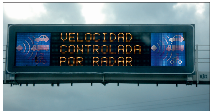
Fot. 3. Przykład znaku o zmiennej treści o rysunku nieciągłym (fot. Leszek Kornalewski)
