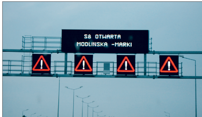
Fot. 13. Dwurzędowa tablica tekstowa o zmiennej treści; pod tablicą umieszczono znaki piktogramowe (fot. Leszek Kornalewski)
