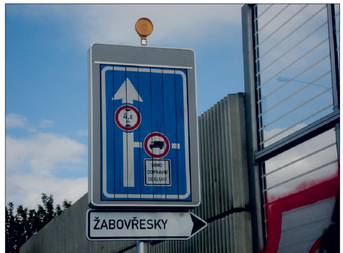
Fot. 2. Przykład znaku o zmiennej treści o rysunku ciągłym (fot. Leszek Kornalewski)
