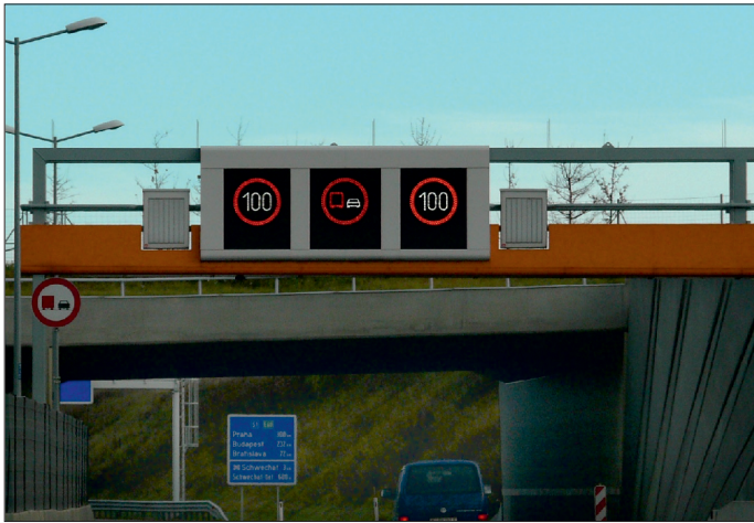
Fot. 4. Przykład piktogramowego zzt; po zewnętrznych stronach pzzt widoczne znaki o rysunku ciągłym (nie wyświetlają komunikatu) (fot. Leszek Kornalewski)
