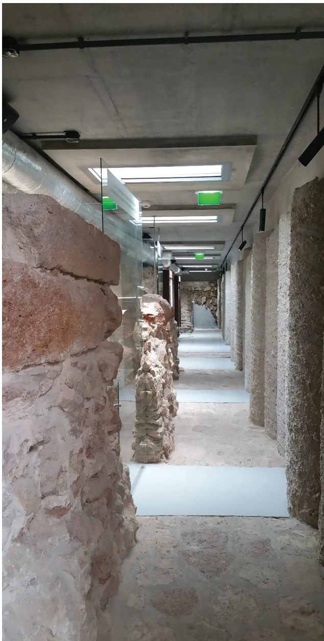
Fot. 3. Żelbetowa palisada i łącznik pod płytą dziedzińca (fot. G. Nawrot)
