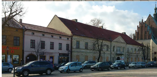
Fot. 4. Elewacja frontowa: stan obecny i przed renowacją (fot. G. Nawrot)
