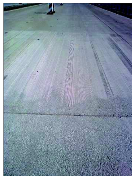
Fot. 20. Widok sfre-zowanych wypukłości płyt betonowych (fot. Stefan Rewiński)
