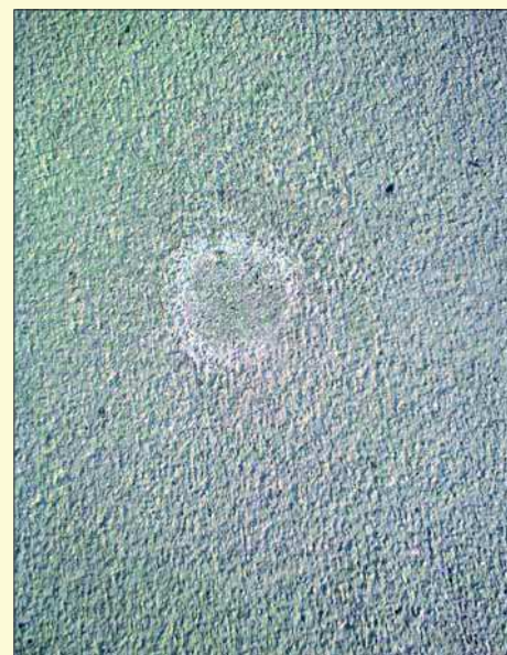
Fot. 27. Widok po naprawie uszkodzenia głębokiego (fot. Stefan Rewiński)
