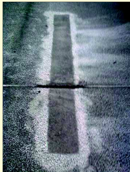
Fot.30. Widok naprawionej nawierzchni na styku dwóch płyt (fot. Stefan Rewiński)
