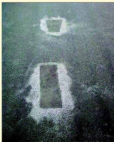
Fot. 32. Widok naprawionych fragmentów powierzchniowych uszkodzeń nawierzchni (fot. Stefan Rewiński)
