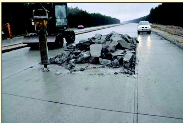
Fot. 22. Widok usuwania wadliwie wykonanej płyty (widoczne nacięcia płyt na krawędziach wewnętrznych przed wyburzeniem). Nacięcia (w odległości 5 cm od krawędzi płyt poprawnie wykonanych) mają na celu uniknięcie uszkodzenia płyt sąsiednich w czasie wyburzania (fot. Stefan Rewiński)
