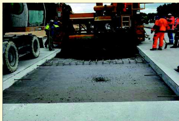
Fot. 24. Wykonywanie płyt po wyburzeniu (widoczny „stołeczek” ze stali zbrojeniowej podtrzymujący dyble w trakcie wbudowywania rozkładarką mieszanki betonu cementowego) (fot. Stefan Rewiński)
