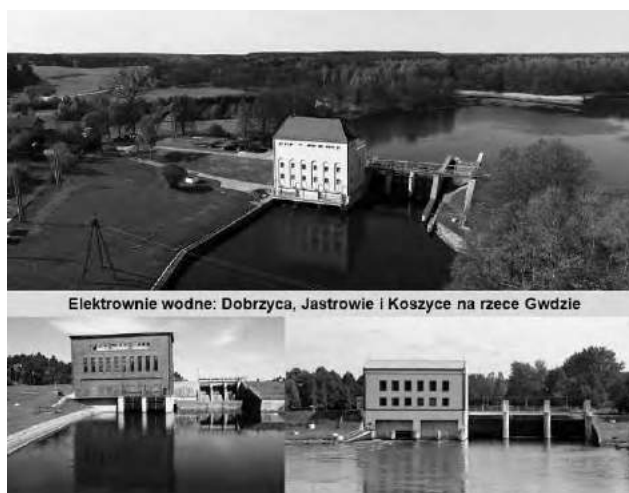
Rys.5 Elektrownie wodne na Gwdzie [3]
