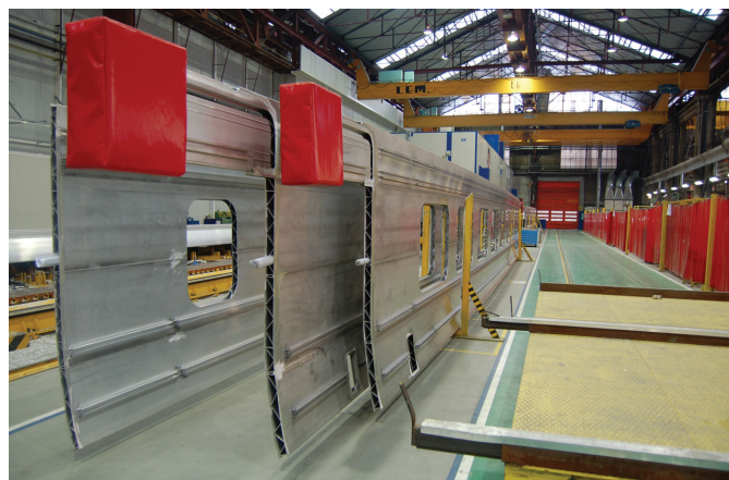
Fot. 5. Ściany boczne po frezowaniu otworów drzwiowych i okiennych
