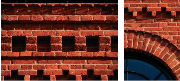
Rys. 5. Przykładowe detale architektoniczne na zabytkowym obiekcie ceglany
