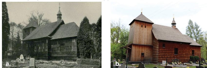
Fot. 3. Widok kościoła w Szalszy. Od lewej: a) widok kościoła od północnego zachodu, fotografia z 1999 r. [11], b) widok kościoła od południa, fotografia własna z 2019 r.
