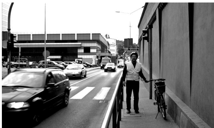
Fot. 1. Nadmierne uszczuplenie przestrzeni pieszej przez realizację celów samochodowych. Projektant, mając do dyspozycji zbyt małą szerokość ulicy, zrealizował w pełni założenia dla ruchu samochodowego, pozostawiając dla ruchu pieszych i rowerzystów łącznie pas terenu o szerokości nie spełniającej wymogów chodnika. Dwa pasy ruchu nie były konieczne z punktu widzenia przepustowości, natomiast ulica stanowi oficjalnie fragment trasy rowerowej I klasy (sic). Rozwiązaniem jest zawężenie jezdni samochodowej do jednego pasa.
