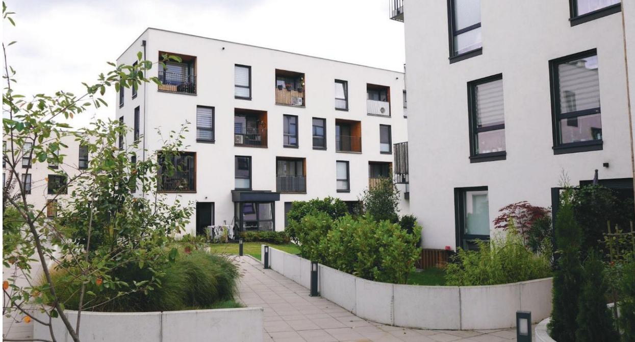
Fot. 6 – mała architektura, oświetlenie oraz zieleń wewnątrz kwartału mieszkaniowego na osiedlu Nowe Żerniki. W tym przypadku dojścia do budynków od wewnątrz kwartału, zieleń i tarasy znajdują się na płycie parkingu podziemnego, umożliwiając efektywne wykorzystanie terenu. fot. Autor Photo 6 – street and landscape architecture within residential quarter in Nowe Żerniki estate. In this case entrances to buildings from interior space, greenery and terraces are located on the underground parking' flat roof slab, allowing effective use of the building plot. Photo by the Author.
