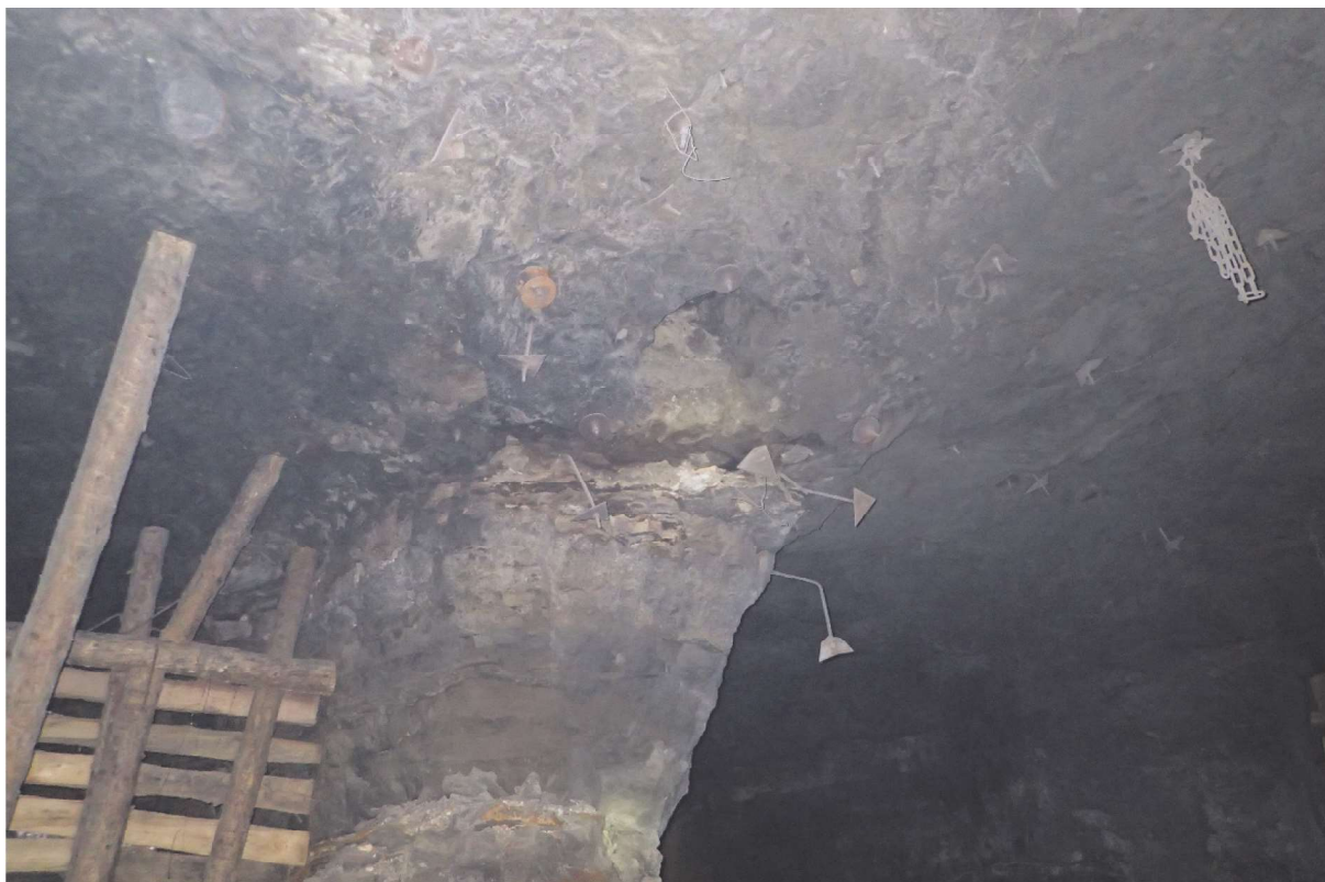
Rys. 9. Fragment podziemnego filara oraz widok stropu zabezpieczonego kotwiami (foto. K. Pytel). Fig. 9. Part of underground pillar and roof reinforced with bolts (photo. K. Pytel)
