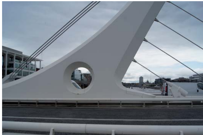
c) utwierdzenie stalowego pylonu w przęsłach
