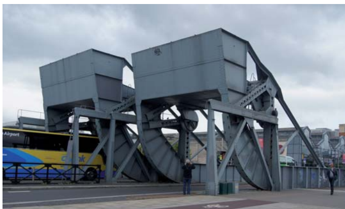
b) skrzynie z balastem w położeniu górnym
