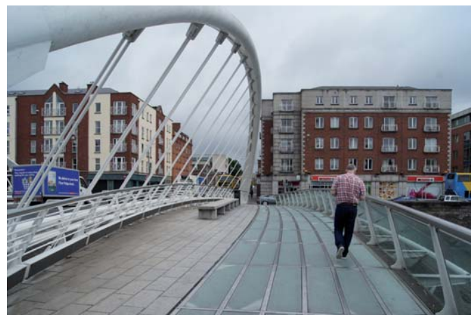
d) chodnik mostu z ławeczką w połowie długości przęsła
