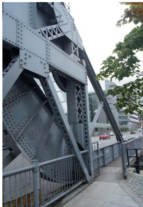
c) kolista powierzchnia toczna podparta stalowym klinem
