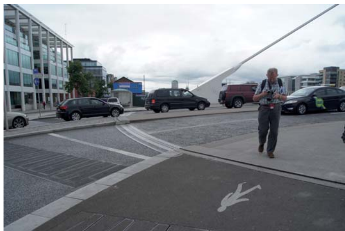
e) przerwa dylatacyjna lewobrzeżna w kształcie odcinka okręgu
