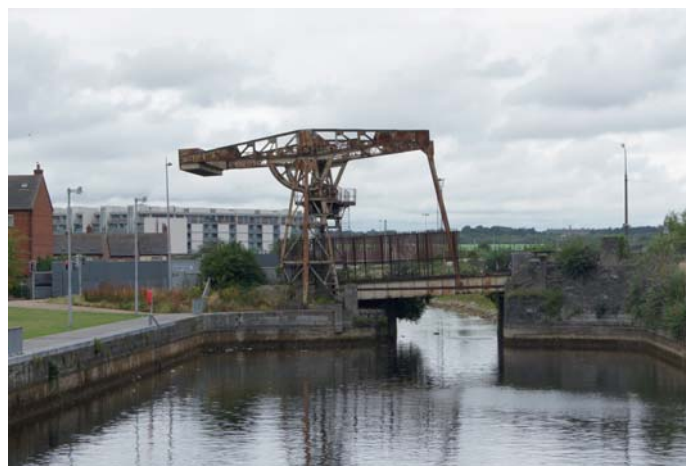
Fot. 9. Most kłapowy przez kanał
