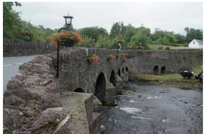
Fot. 1. Mosty kamienne na drogach Irlandii
