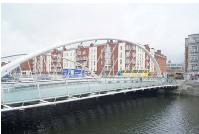
b) rozchylone łuki mostu
