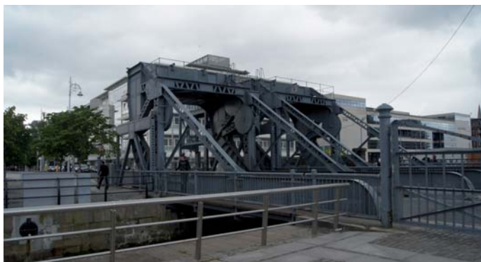
a) widok bliźniaczych konstrukcji dwóch mostów
