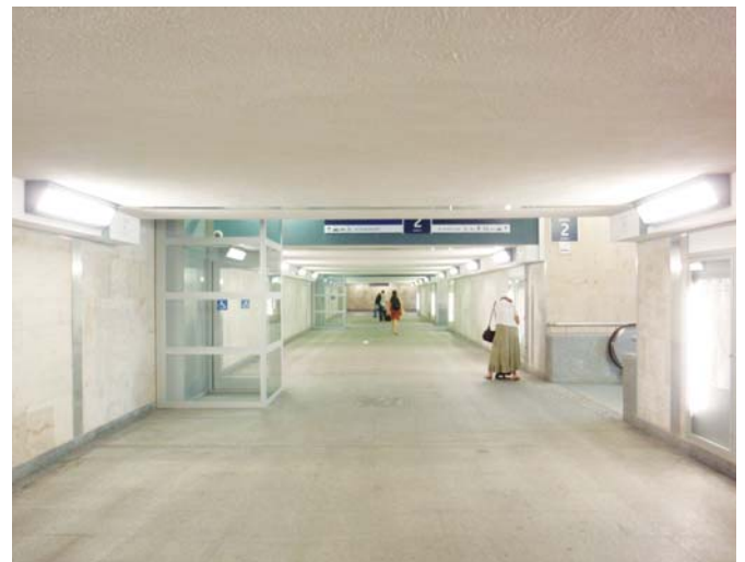
Fot. 11. Zawężenie centralnego tunelu przez zabudowę wind. Fot. A. Molecki
