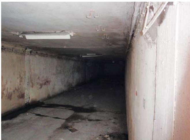
Fot. 8. Korytarz techniczny starego dworca w Katowicach. Fot. A. Molecki
