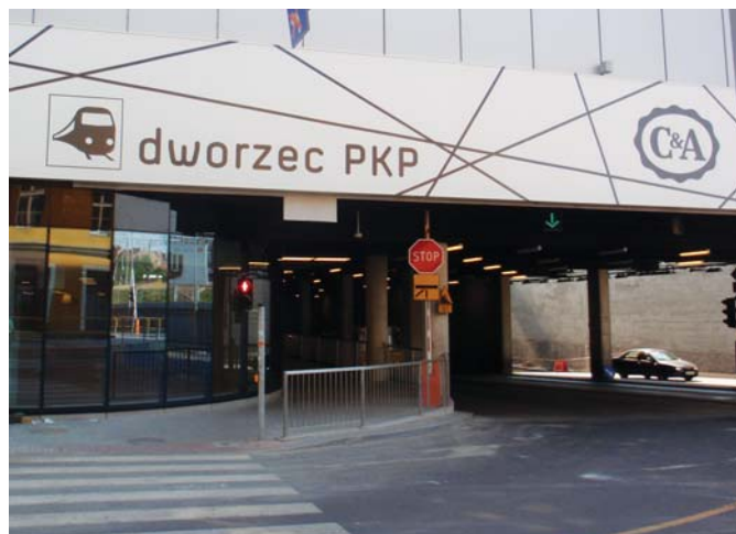
Fot. 6. Wejście do hali dworcowej od zachodu prowadzi przez długi i nieprzyjazny tunel pieszo-drogowy. Fot. A. Molecki
