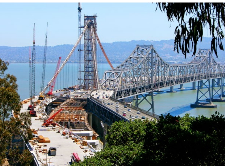
SAS w trakcie budowy pylonu w 2011 r., fot. K. Dąbrowiecki
