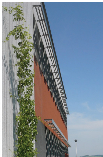
Rys. 1. Szkoła pasywna w Budzowie z zaznaczeniem badanej klasy (po lewej) oraz światłolamcze na elewacji wschodniej (po prawej) (archiwum autorki)
