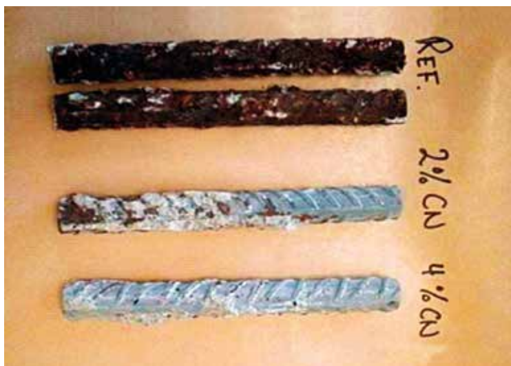
Rys. 6. Pręty zbrojeniowe wyjęte z cylindrów betonowych z domieszką 3,2% NaCl po 4 latach przechowywania w temperaturze 38°C przy wilgotności względnej 90%. Górne pręty z wzorca, pręt środkowy z betonu z 2% CN, a dolny pręt z betonu z 4% CN
