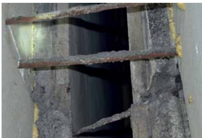
Rys. 22. Widok na pręty montażowe pozostawione z czasów budowy budynku
