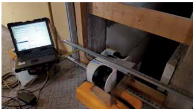
Rys. 20. Pomiar szczeliny dylatacyjnej za pomocą skanera laserowego ze specjalnie przygotowanego pomostu
