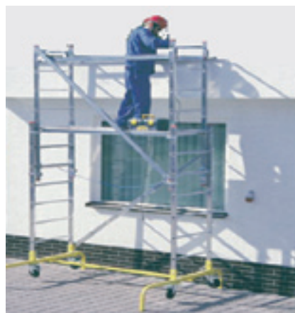
Fot. 1. Praca przy elewacji budynków
