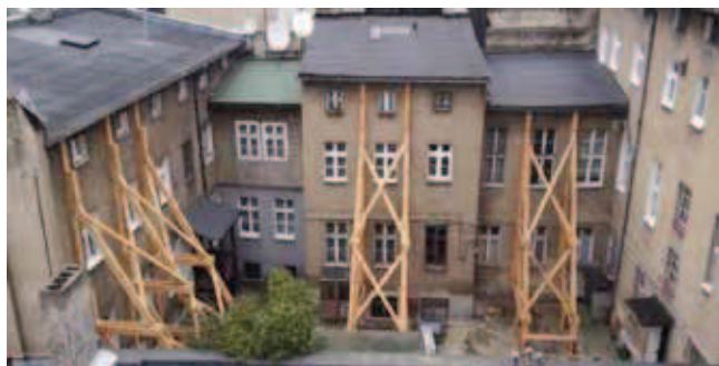
Rys. 2. Drewniana konstrukcja podpierająca budynek przy ul. Garbary 47 (fot. W. Wierzbicki, 2015)
