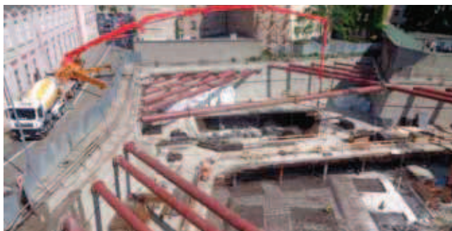
Rys. 4. Betonowanie płyty fundamentowej z ulicy Za Bramką (fot. W. Wierzbicki, 2015)
