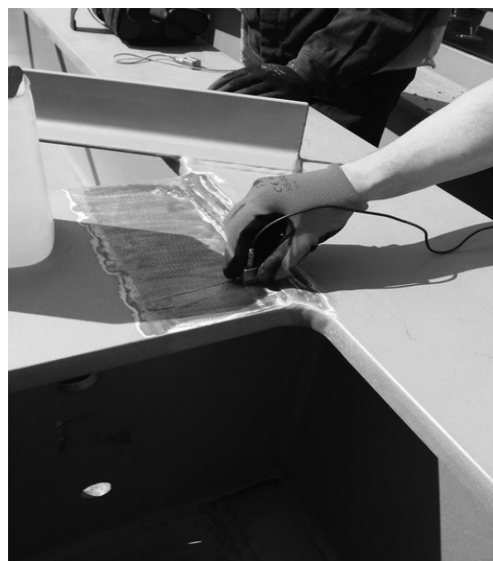
Rysunek 3. Głowica podczas badania trzymana pod odpowiednim kątem. Jako nośnika fal użyto specjalnego preparatu. Źródło: Jedna z analiz technicznych konstrukcji stalowych wykonywana przez Centrum Rzeczoznawstwa Budowlanego Sp. z o.o.
