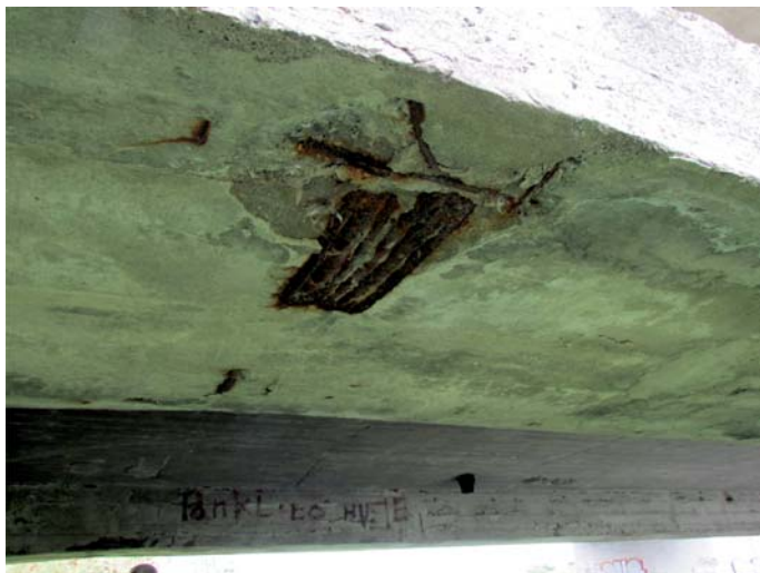
Fot. 7. Typowe uszkodzenia konstrukcji: a) odsłonięte pręty zbrojeniowe ściągu, b) korozja odsłoniętych kabli sprężających
