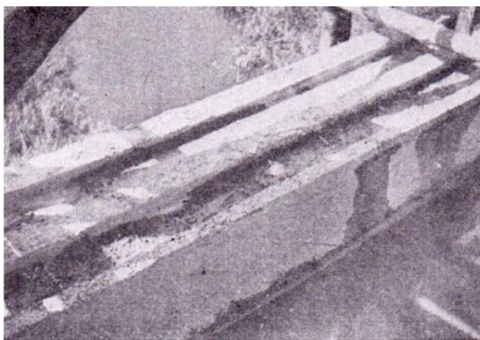
Fot. 2. Kanały na kable sprężające w ściągę [1]
