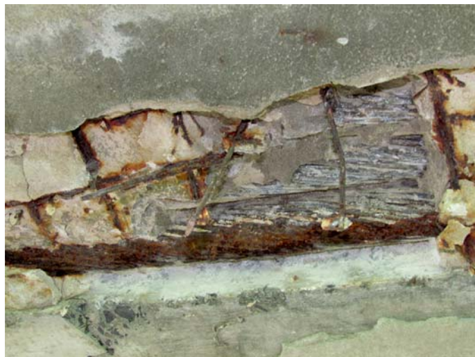
Fot. 7. Typowe uszkodzenia konstrukcji: a) odsłonięte pręty zbrojeniowe ściągu, b) korozja odsłoniętych kabli sprężających
