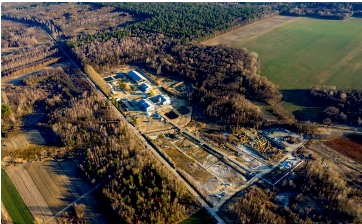
Rys 3. Zabudowa przemysłowa Kopalni Polska Siarka Sp. z o. o. na złożu Basznia - I [Polska Siarka Sp. z o. o.]
