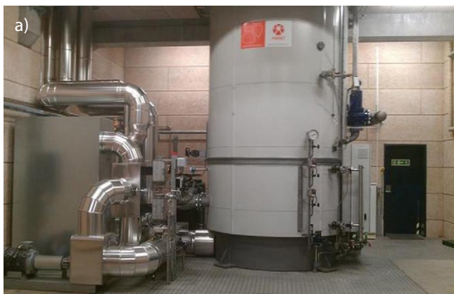
Rys. 5. Kocioł elektrodowy: przykład zainstalowanego kotła elektrodowego o mocy 10 MW firmy Parat w Danii (a), schemat kotła (b)
