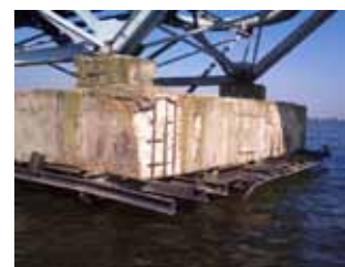
Rys. 3, 4. Uszkodzenia podpór w postaci odpadającego skorodowanego betonu i skorodowanej stali zbrojeniowej
