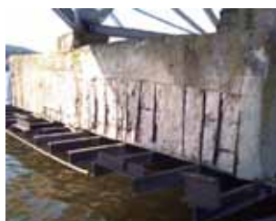
Rys. 3, 4. Uszkodzenia podpór w postaci odpadającego skorodowanego betonu i skorodowanej stali zbrojeniowej
