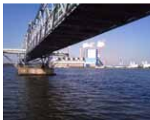
Rys. 1. Widok mostu hydraulicznego odpopielania wraz z analizowaną podporą
