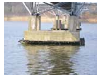
Rys. 2. Widok pojedynczej nawodnej podpory
