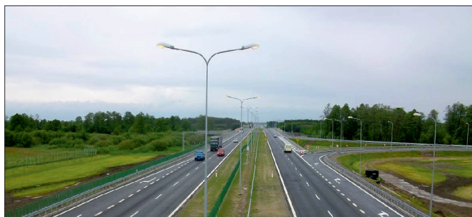
Fot. 1. Widok drogi ekspresowej S17
