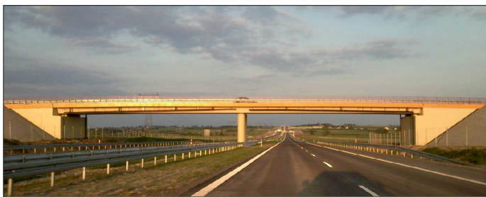
Fot. 2. Wiadukt WD-09 w ciągu drogi poprzecznej
