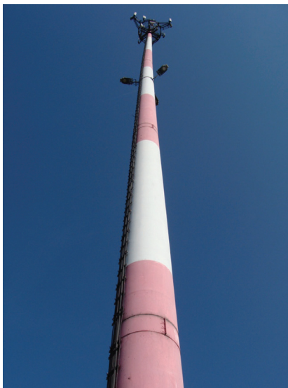
Fot. 1. Widok ogólny wieży
