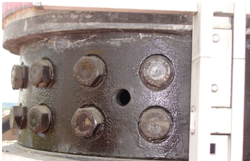
Fot. 2. Szczegół złącza segmentów wieży
