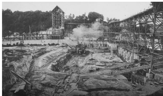
Rys. 3. Elektrownia Mühleberg w trakcie budowy (źródło: wikipedia)
