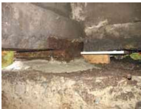
Rys. 7. Tymczasowe zabezpieczenie – nakładanie zaprawy (oczep filara)
