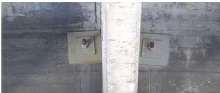
Rys. 6. Widok na poprzecznicę i ściągi w sąsiedztwie dźwigara środkowego nad filarem
