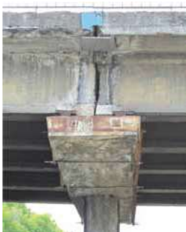
Rys. 9. Oczep filara przed końcowym remontem w czerwcu 2013 roku
