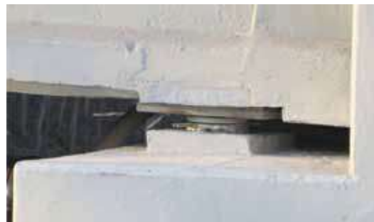
Rys. 14. Łożysko – przyczółek wschodni, strona południowa (po remoncie)
