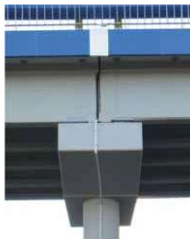
Rys. 10. Oczep filara po remoncie w listopadzie 2013 roku
