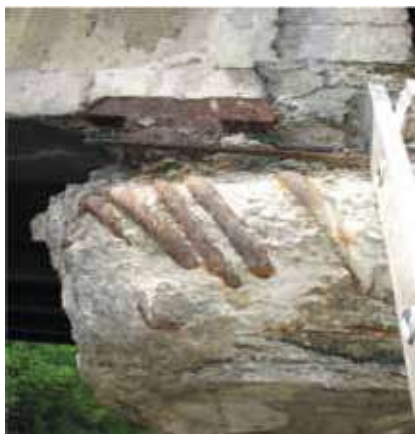
Rys. 2. Łożysko skrajne na filarze – strona południowa-zachodnia (przed remontem)
