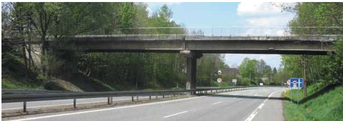
Rys. 1. Widok wiaduktu od strony południowej w czerwcu 2011 roku, przed remontem Fig. 1. View of the bridge from the south side in June 2011 year, before renovation
