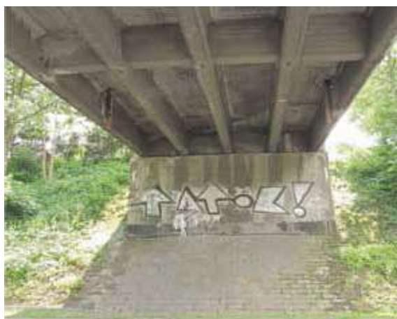
Rys. 11. Przyczółek zachodni przed remontem
