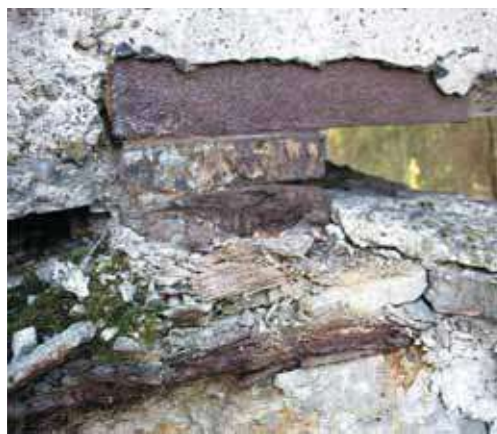
Rys. 3. Łożysko skrajne na filarze – strona północno-zachodnia (przed remontem)
