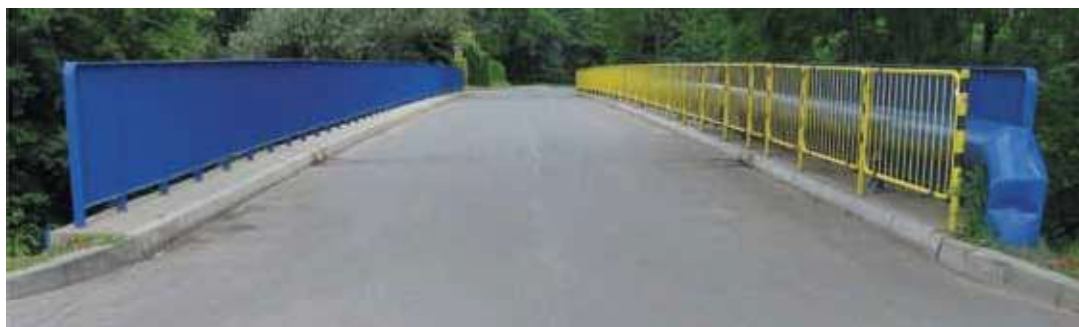
Rys. 15. Widok od strony wschodniej na jezdnię na wiadukcie w lipcu 2017 roku
