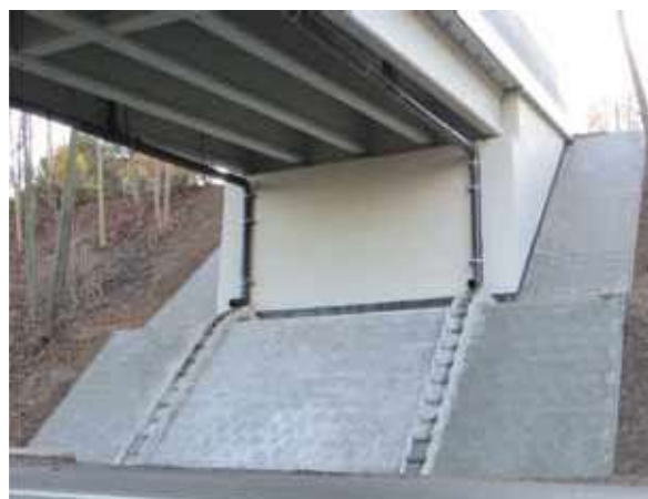
Rys. 12. Przyczółek zachodni po remoncie
