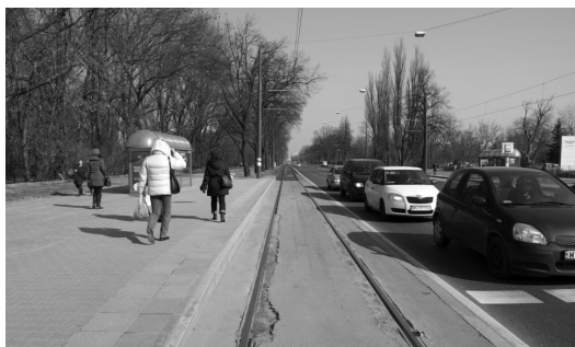
Fot. 8. Torowisko po obu stronach jezdni w al. Waszyngtona w Warszawie
