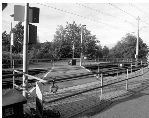
Fot. 12 Miejsce wypadku śmiertelnego na dobrze zabezpieczonym przejściu typu „Z” przez tram-way w Stuttgarcie
