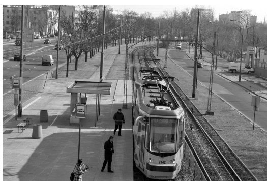
Fot. 7. Torowisko pomiędzy jezdniami głównymi i jezdnią lokalną na ul. Jagiellońskiej w Warszawie
