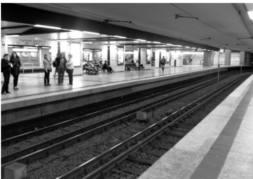
Fot. 17. Przystanek tramwajo- wy pod centrum Stuttgartu
