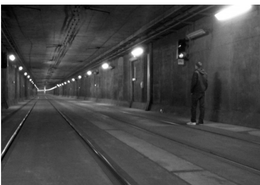
Fot. 18. Tunel tramwajowy w Krakowie; fot. Michał Lorenz
