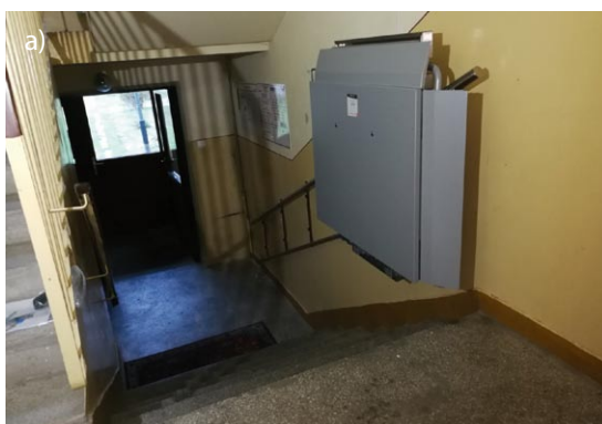
Rys. 8. Przykład dobudowanego dźwigu umożliwiającego dostęp do mieszkania znajdującego się na parterze budynku 4-piętrowego
