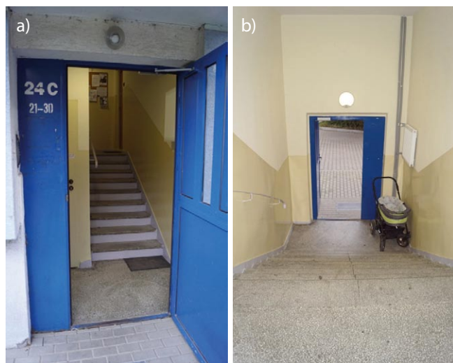
Rys. 2. Schody prowadzące na parter w budynkach 4-piętrowych
