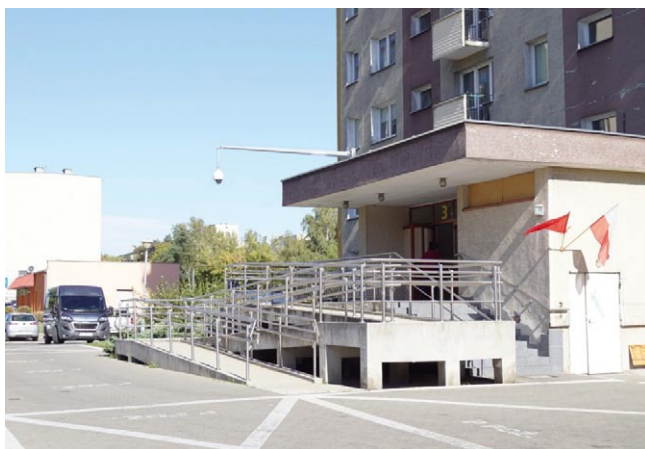
Rys. 7. Widok pochylni dobudowanej do obiektu wysokiego
