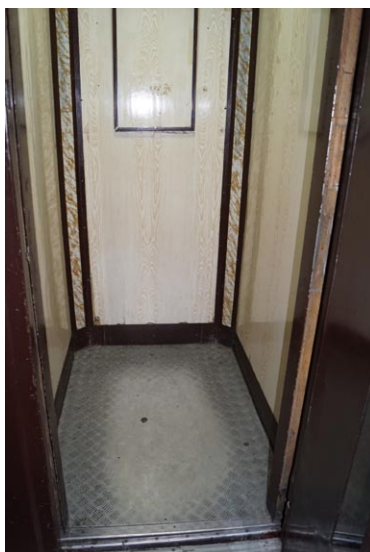
Rys. 12. Widok wnętrza niewielkiej kabiny dźwigu osobowego (szer. 98 cm, gł. 135 cm)
