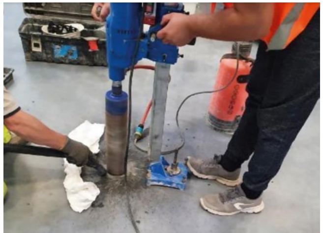
Rys. 7. Pobranie próbek betonu do badania niszczącego
