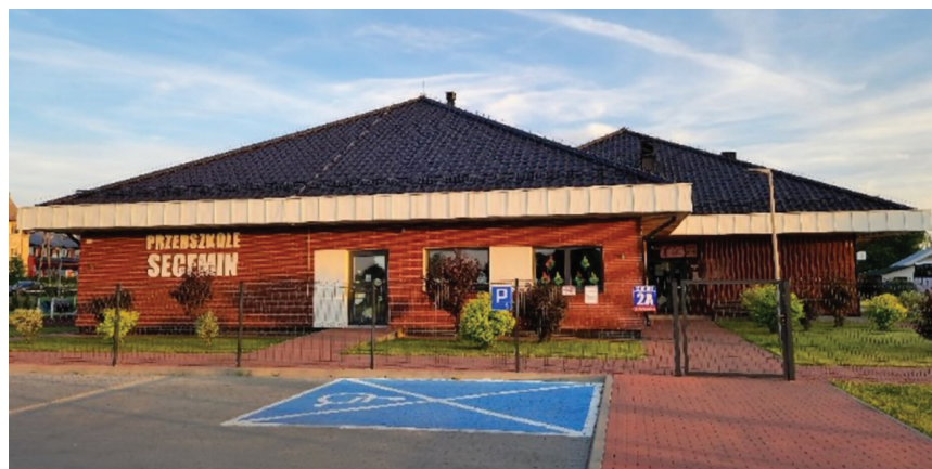
Rys. 1. Widok od frontu Publicznego Przedszkola w Seceminie; źródło: fot. własna
