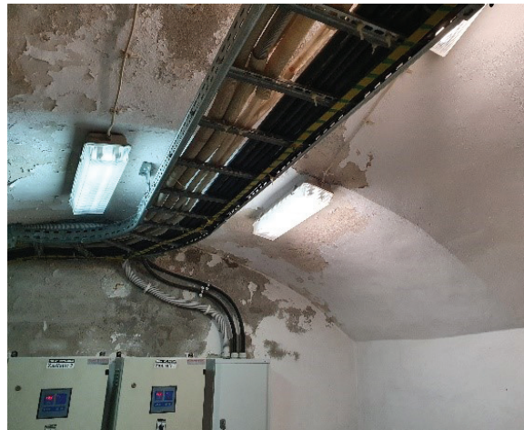
Rys. 3. Analizowany obszar demontażu stropu. Fot. M. N-Pieńkowska 2021 Fig. 3. Analyzed area of ceiling disassembly. Photo M. N-Pieńkowska 2021
