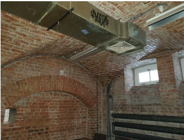
Rys. 2. Układ stropu kolebkowego. Fot. M. N-Pieńkowska 2021 Fig. 2. Barrel ceiling. Photo M. N-Pieńkowska 2021
