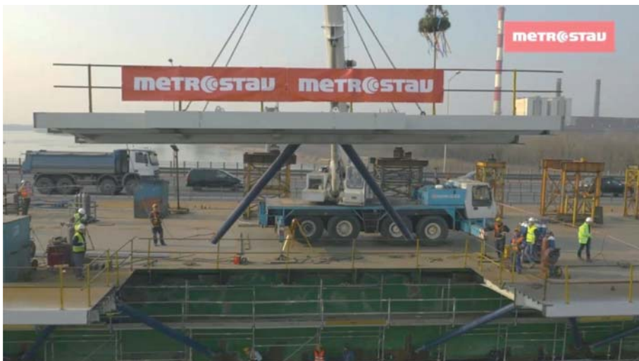
Fot. 4. Montaż zewnętrznego segmentu z 2 rurami skratowania
