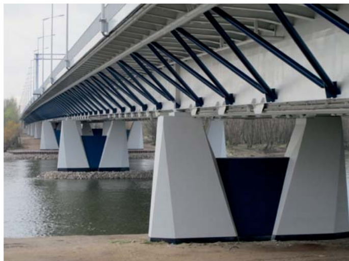
Fot. 7. Porównanie widoków mostu przed i po przebudowie
