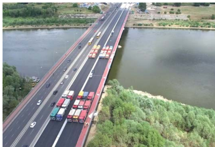
Fot. 6. Próbné obciążenie nitki południowej
