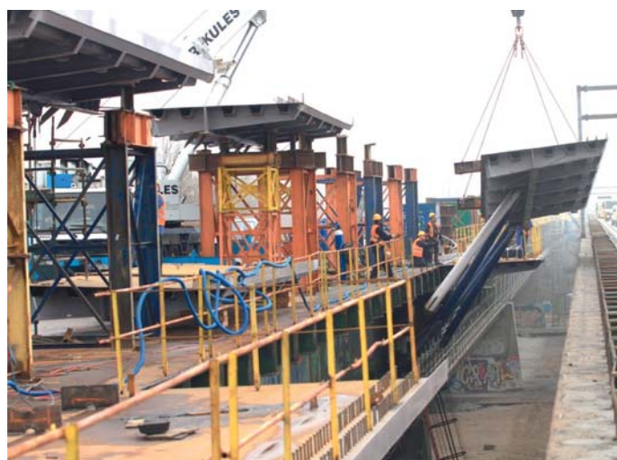
Fot. 5. Montaż wewnętrznego segmentu z 4 rurami skratowania
