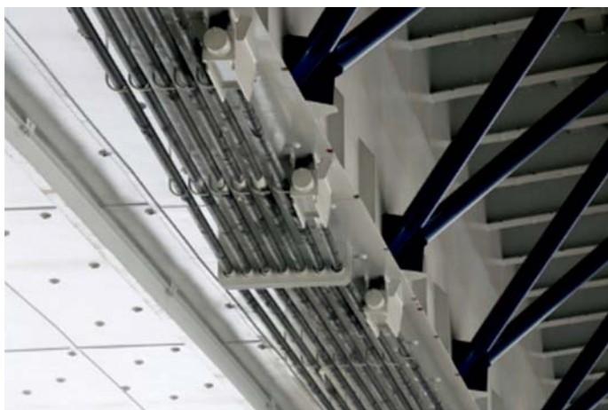
Fot. 2. Sprężenie dolne w przęśle nurtowym
