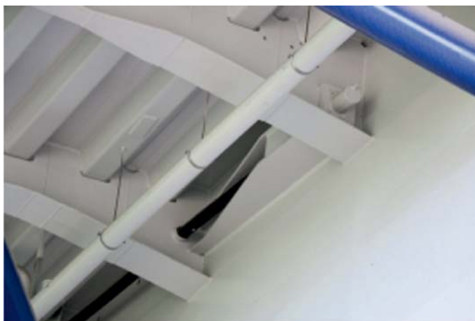
Fot. 3. Zakotwienie sprężenia górnego
