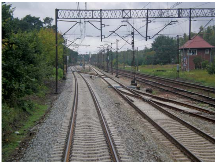
Fot. 4. Posterunek odgąteźny Bydgoszcz Leśna na zrewitalizowanym odcinku Toruń – Bydgoszcz na linii nr 18
