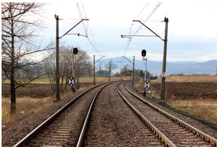
Fot. 8. Tory na szlaku Boguszów Gorce Zachód - Sędziszów na linii nr 274 po wykonanej rozszerzonej naprawie bieżącej. Po naprawie prędkość pociągów została zwiększona z 30 km/h do 80 km/h
