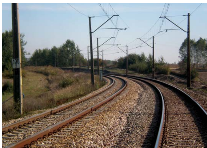
Fot. 1. Szlak Jastrząb – Szydłowiec na linii nr 8 po rewitalizacji – tor nr 1 (lewy) po kompleksowej wymianie, tor nr 2 (prawy) po oczyszczeniu podsypki i regulacji położenia
