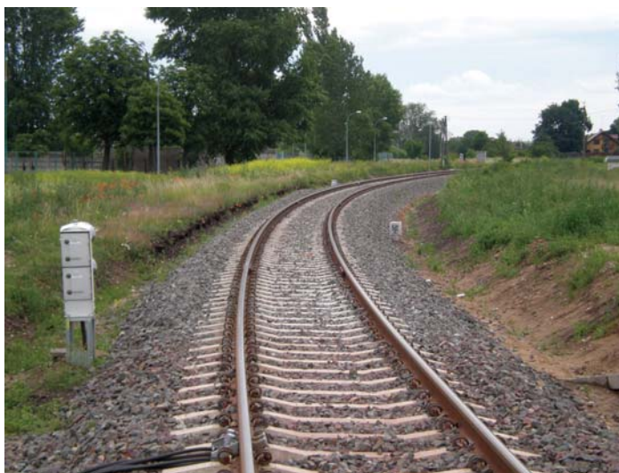
Fot. 6. Zmodernizowany odcinek linii nr 356 Poznań Wschód – Wągrowiec w rejonie stacji Wągrowiec
