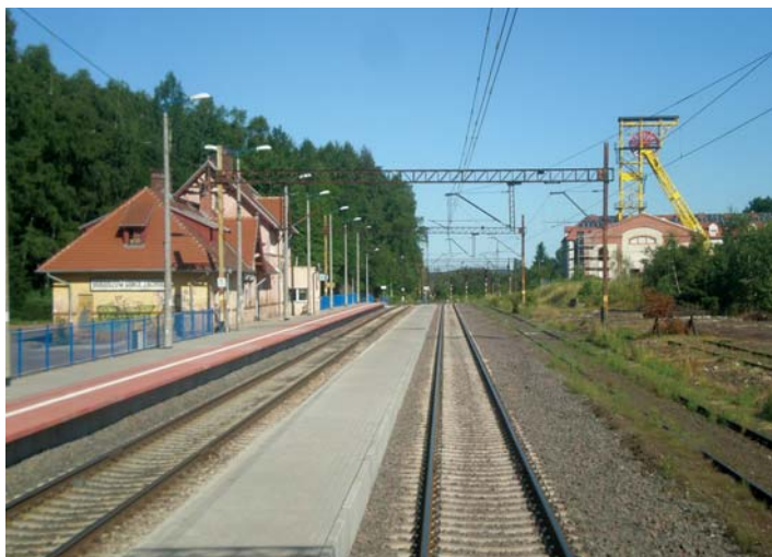
Fot. 3. Wykonane roboty rewitalizacyjne na stacji Boguszów Gorce Zachód na linii nr 274 Wrocław – Jelenia Góra – Zgorzelec
