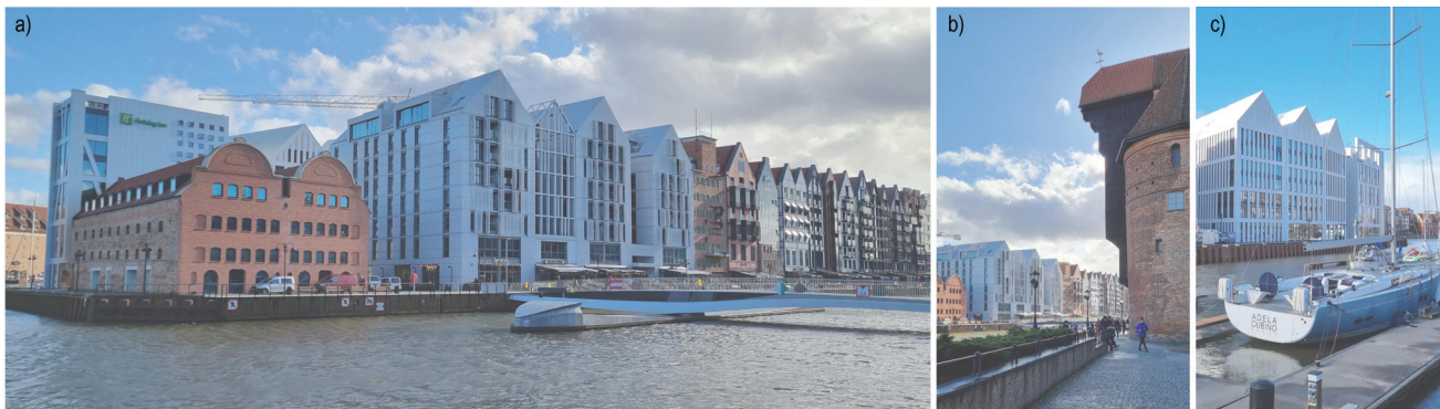
Fot. 3. Współczesna zabudowa północnego cypla Wyspy Spichrzów; a) wschodnia pierzeja zabudowy cypla sąsiadująca z zabytkową zabudową Głównego Miasta. Połączenie brzegów za pomocą nowoczesnej obrotowej kładki. Od lewej – zabudowa kompleksu Granaria, a w tym odbudowane spichlerze Daleka Droga. W tle także zrewitalizowany Spichlerz Deo Gloria rozpoczynający zabudowę kompleksu Deo Plaza; b) widok na nową zabudowę z bulwaru Długiego Pobrzeża. W tle zabytkowy Żuraw; c) widok od strony mariny na kompleks Granaria; źródło: fot. własna
