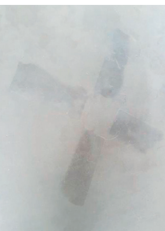
Ślady obróbki mechanicznej za pomocą zacieraczek na powierzchni posadzki
