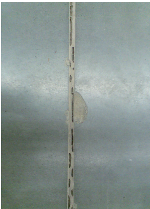
Rozerwanie masy elastycznej na skutek zjawiska skurczu
