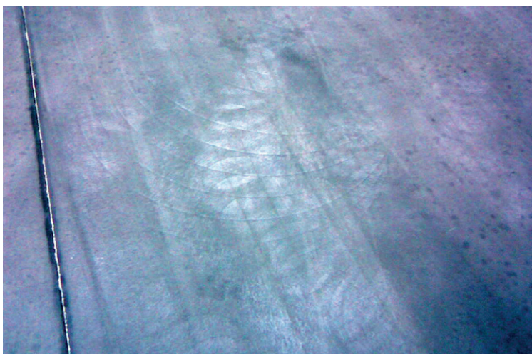
Ślady obróbki mechanicznej za pomocą zacieraczek na powierzchni posadzki
