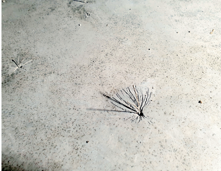
Z lewej: włókna polipropylenowe na powierzchni posadzki.
